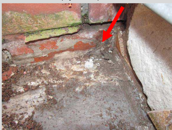
Fot. 01_2 Okładzina z płytek gresowych spękana, odspojona od podłoża.
