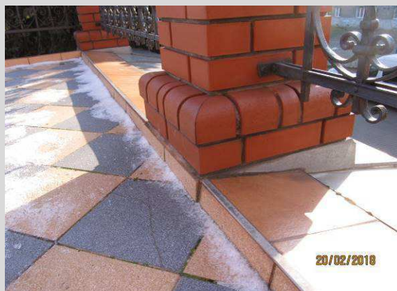
FOT_33 Widok przykładowych spękań okładziny ceramicznej.
