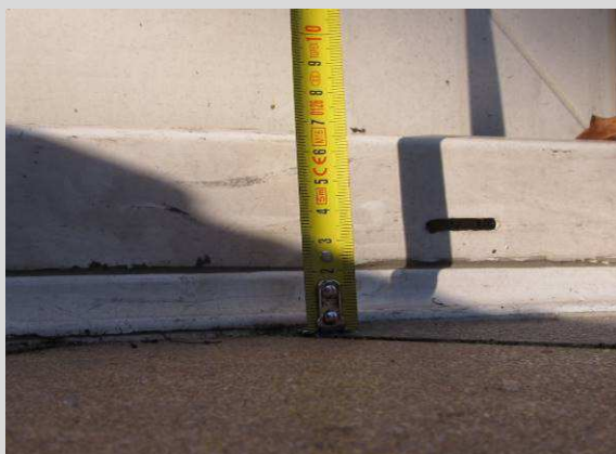
FOT_31 Obecny poziom warstw tarasowych na poziomie ~3cm poniżej otworów odwodnieniowych ram okiennych.
