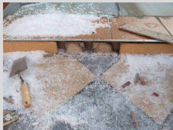
Fot. 02_2 Płytki cokołowe klejone „na placki”.
