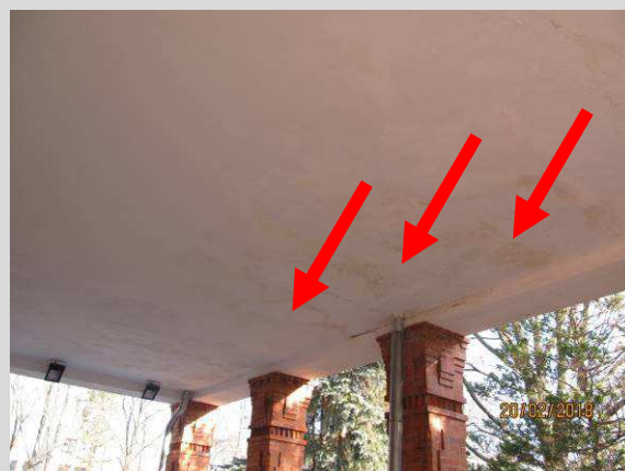
FOT_6. Widok przykładowych zawilgocień i wysoleń na dolnej powierzchni płyty stropowej.
