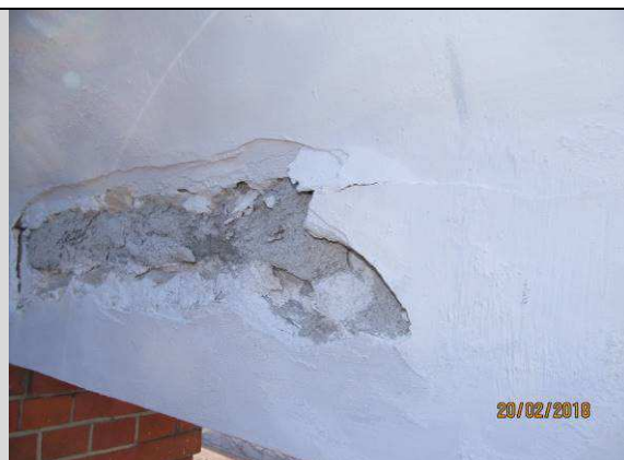
FOT_9, FOT_14 Widok przykładowych ubytków warstw tynkarskich.
