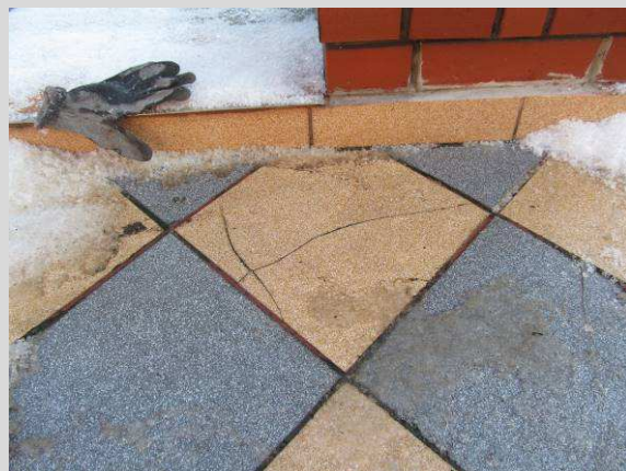
Fot. 03_2. Okładzina z płytek gresowych spękana, odspojona od podłoża.
