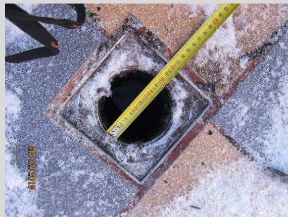
FOT_23. Wpust podłogowy Dallmer DN100.
