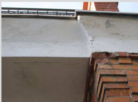
FOT_13 Przykładowy fragment odspojonego tynku stanowiącego zagrożenie upadkiem z wysokości.
