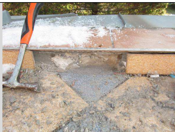
Fot. 02_5 Murek obwodowy wykonany na powierzchni okładziny ceramicznej z płytek.
